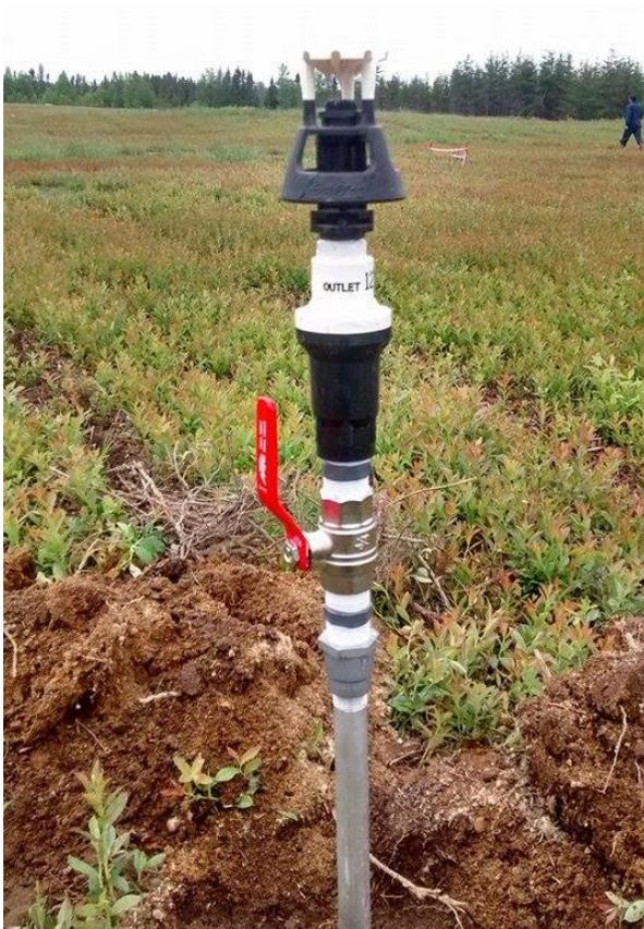
Figure 65 : Gicleur Xcel-Wobbler® avec un régulateur de pression (12 psi) et une valve – Saint-David-de-Falardeau.
