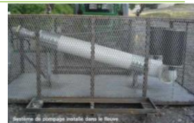
Pompes de pompage installées dans le fleuve
