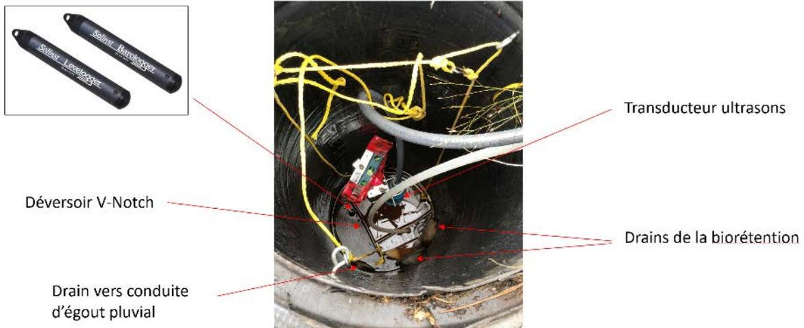
Figure 7 : Vue du système de mesure de débits sortant à l'intérieur du puisard de la BR-4.
