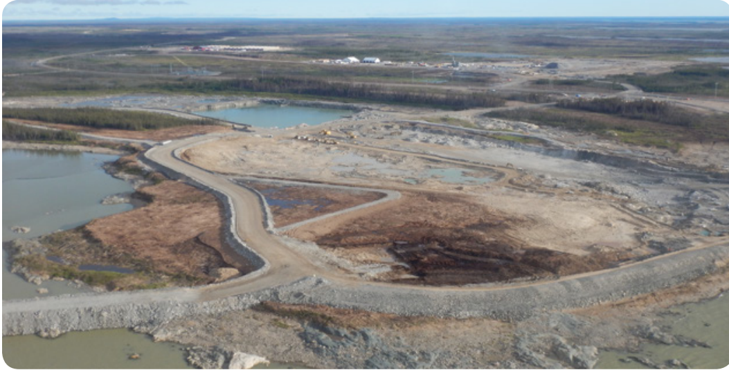
Figure CS4.5 Photo du site de la centrale de Keeyask en construction (21 juin 2015)
