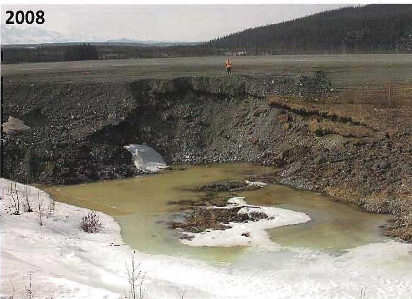
Figure 2 : Effondrement associé à la fonte de glace au site Dry Creek, Alaska Highway, Yukon.
