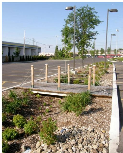
Figure 2 : Implantation de PGOSV à l'échelle du site. Zone de biorétention dans le stationnement du Mountain Equipment Coop, Longueuil, QC
