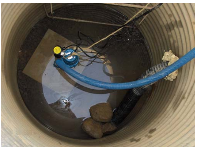
Figure M.9 : Accès au puits et installation de la pompe submersible.
