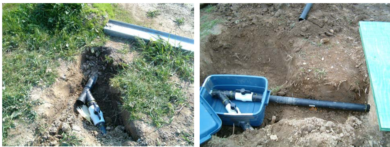
Figure M.11 : Installation du circuit de contournement bi-valves
