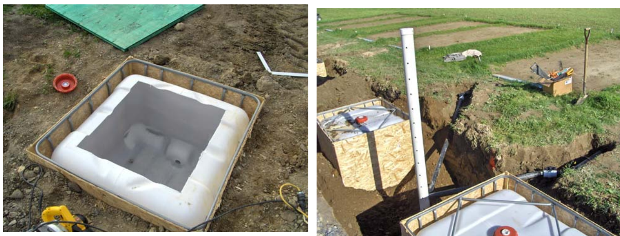
Figure M.10 : Aménagement des réservoirs et raccordement aux parcelles
