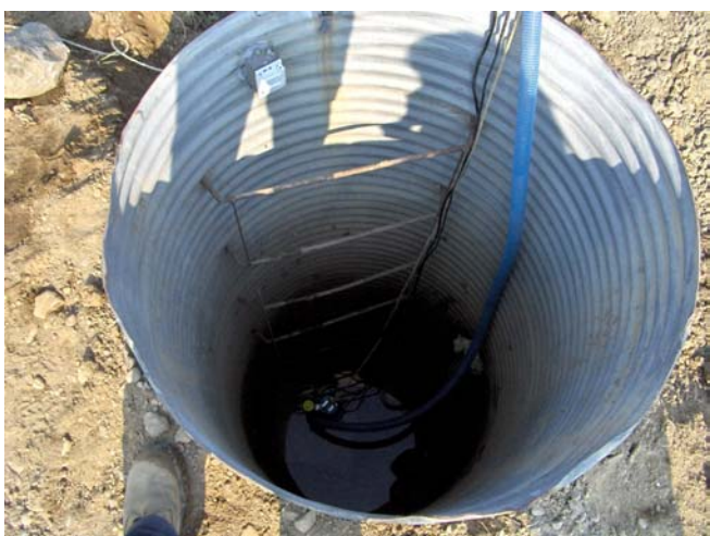
Figure M.9 : Accès au puits et installation de la pompe submersible.
