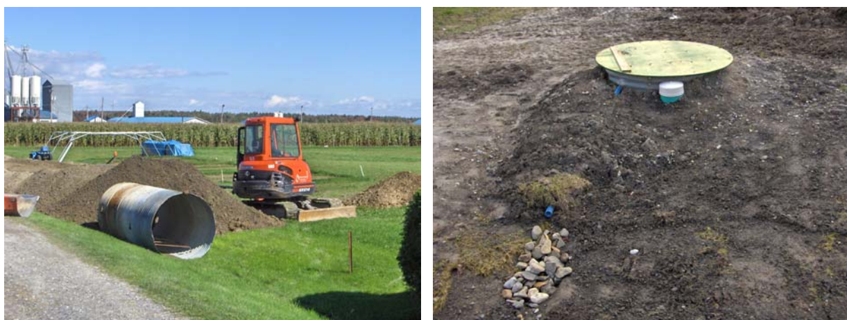
Figure M.7 : Aménagement de la station de pompage
