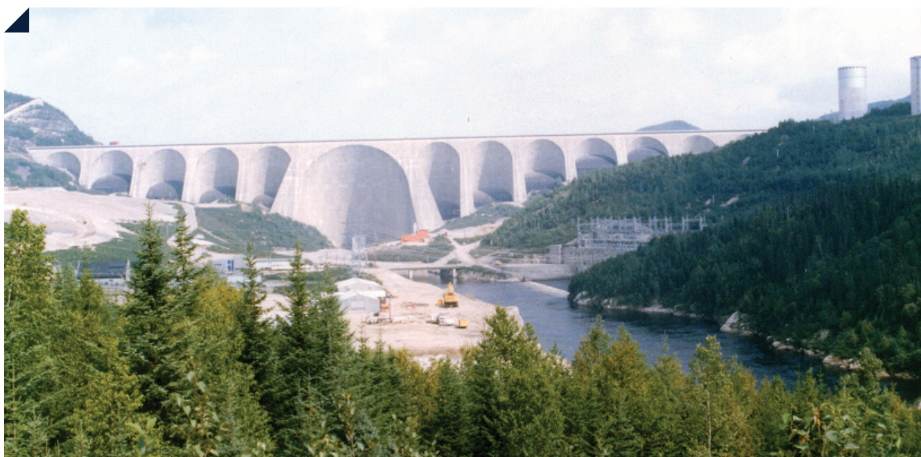
Barrage Daniel-Johnson à Manic-5
