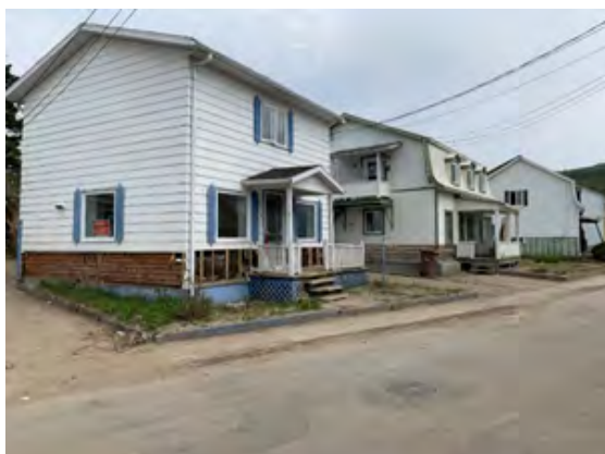
Figure 4: Le niveau d'eau atteint lors des inondations du printemps 2023 à Baie-Saint-Paul est visible sur cette rangée de maisons.
