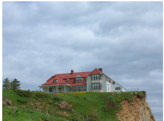
Figure 4: La villa Frédérick-James avant son déplacement. Vue de la façade.
