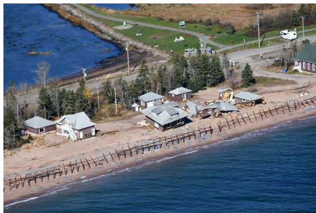
Figure 1: Le Château Dubuc après le passage de la tempête Fiona en septembre 2022
