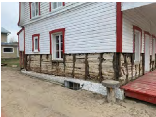
Figure 3: Maison en pièce sur pièce dont le parement a été retiré après les inondations du printemps 2023 à Baie-Saint-Paul
